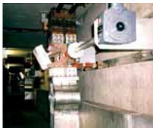
Разъединитель большой мощности MBD (много-ножевой разъединитель) диапазона. 2000В, DC от 5000 до 60000А Однополюсный / Двухполюсный/ на 2 направления. Производство меди или алюминия.
