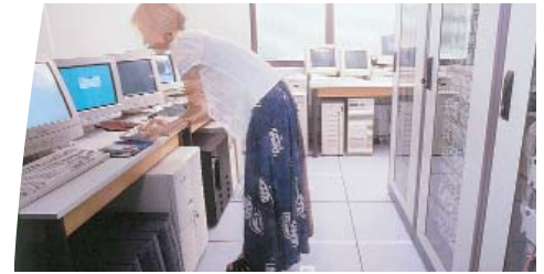
Серверные залы и электронные хранилища данных, активное сетевое оборудование, Дата Центры итд.
