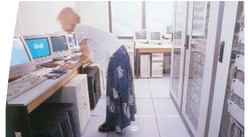
Дата Центры, банковский сектор, хранилища данных, резервное оборудование, активное сетевое оборудование, и т. д.
