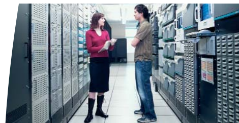
Вычислительные центры: серверные помещения, коммуникационные центры, устройства хранения информации, сетевое оборудование
