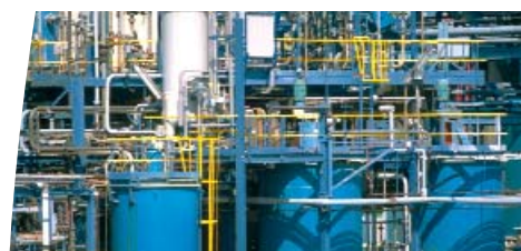
Индустриальные процессы: контроль работы печей, автоматических производственных линий, измерительных механизмов, аварийного освещения, сигнализации
