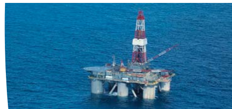
Нефтепереработка, нефтяные платформы, контрольные и машинные залы, циркуляционные насосы для жидкостей (вода, газ, и т. д.), радио системы
