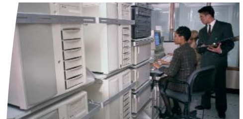
Вычислительные центры: серверные помещения, коммуникационные центры, устройства хранения информации, сетевое оборудование
