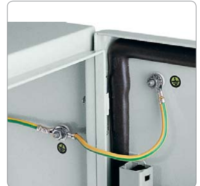
Болты заземления, приваренные к корпусу и двери
